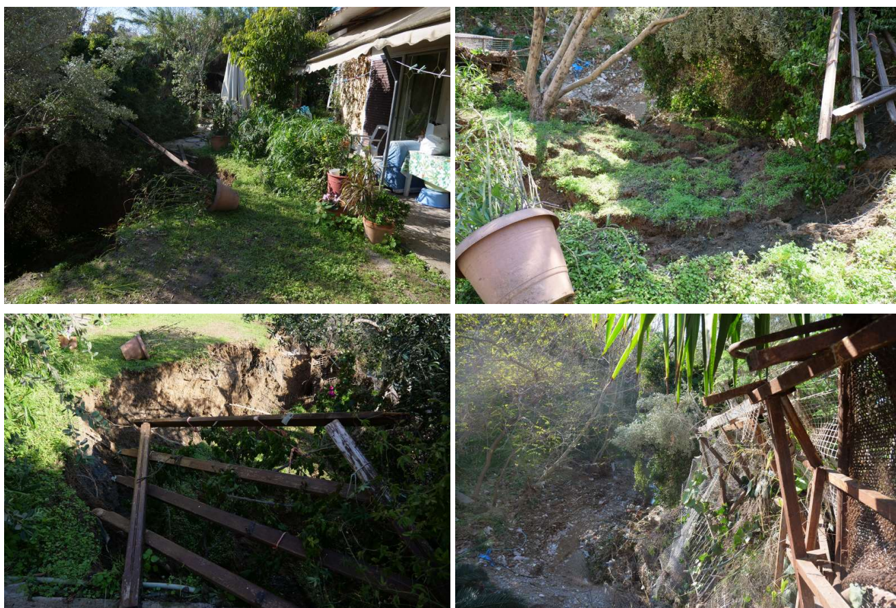
Εικόνα 9: Φωτογραφίες της κατολίσθησης στην περιοχή 3 (πηγή: αυτοψία BEYOND/FloodHub στις 27/12/2025)
