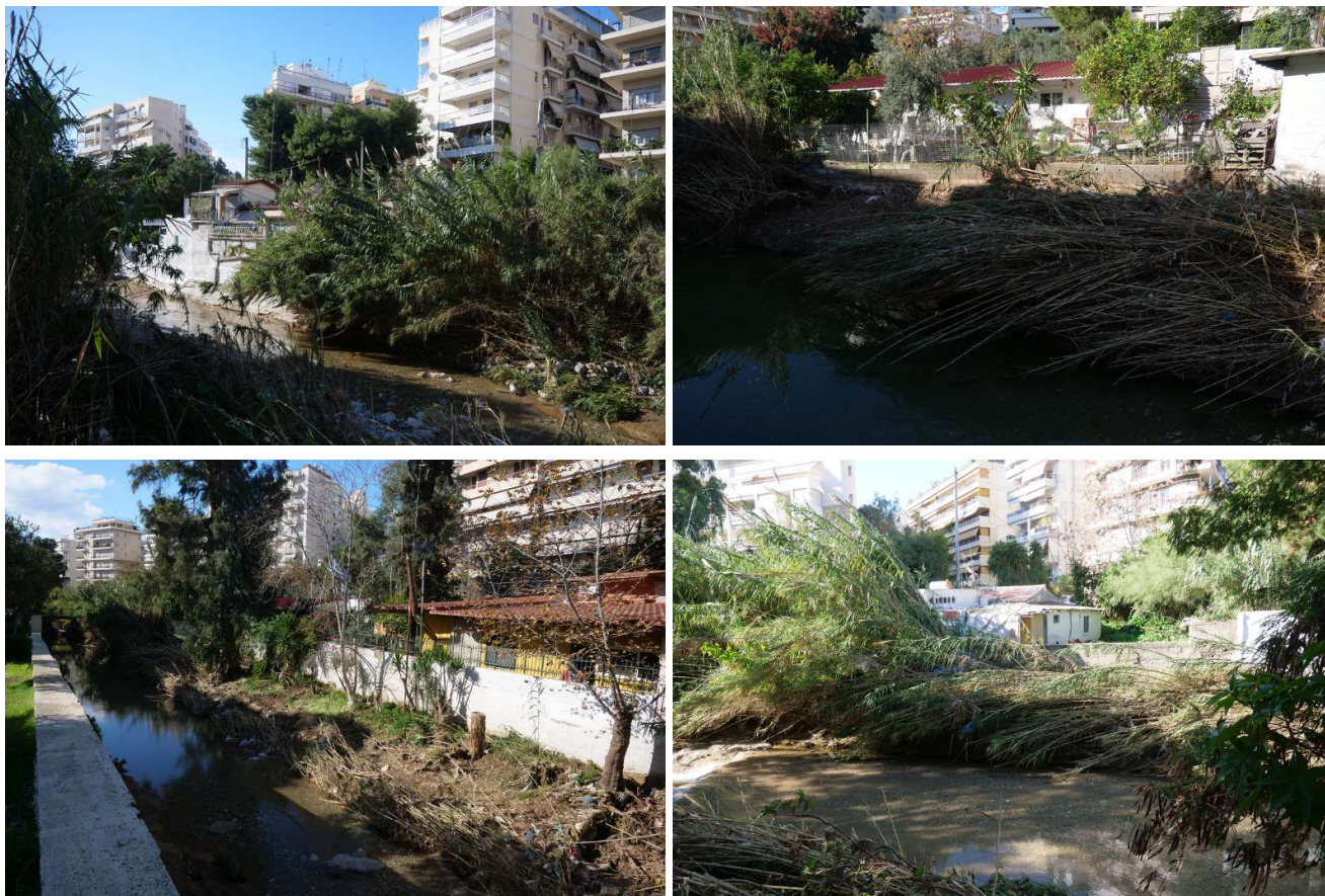
Εικόνα 6: Φωτογραφίες των κτισμάτων εντός της κοίτης του ρέματος Πικροδάφνης, στη δεξιά όχθη, μεταξύ των λεωφόρων Ποσειδώνος και Αμφιθέας, περιοχές 1 & 2 (πηγή: αυτοψία BEYOND/FloodHub στις 27/12/2025)
