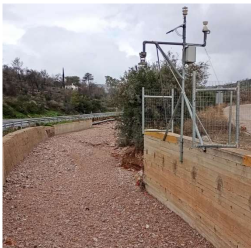
Φωτογραφίες 3 & 4 (στις 7/12/2025): Το ρέμα Σούρες στον σταθμό Ρέμα μετά την κακοκαιρία Byron με φερτά υλικά ύψους 1,00 m
