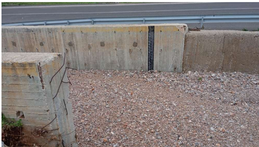
Φωτογραφίες 3 & 4 (στις 7/12/2025): Το ρέμα Σούρες στον σταθμό Ρέμα μετά την κακοκαιρία Byron με φερτά υλικά ύψους 1,00 m
