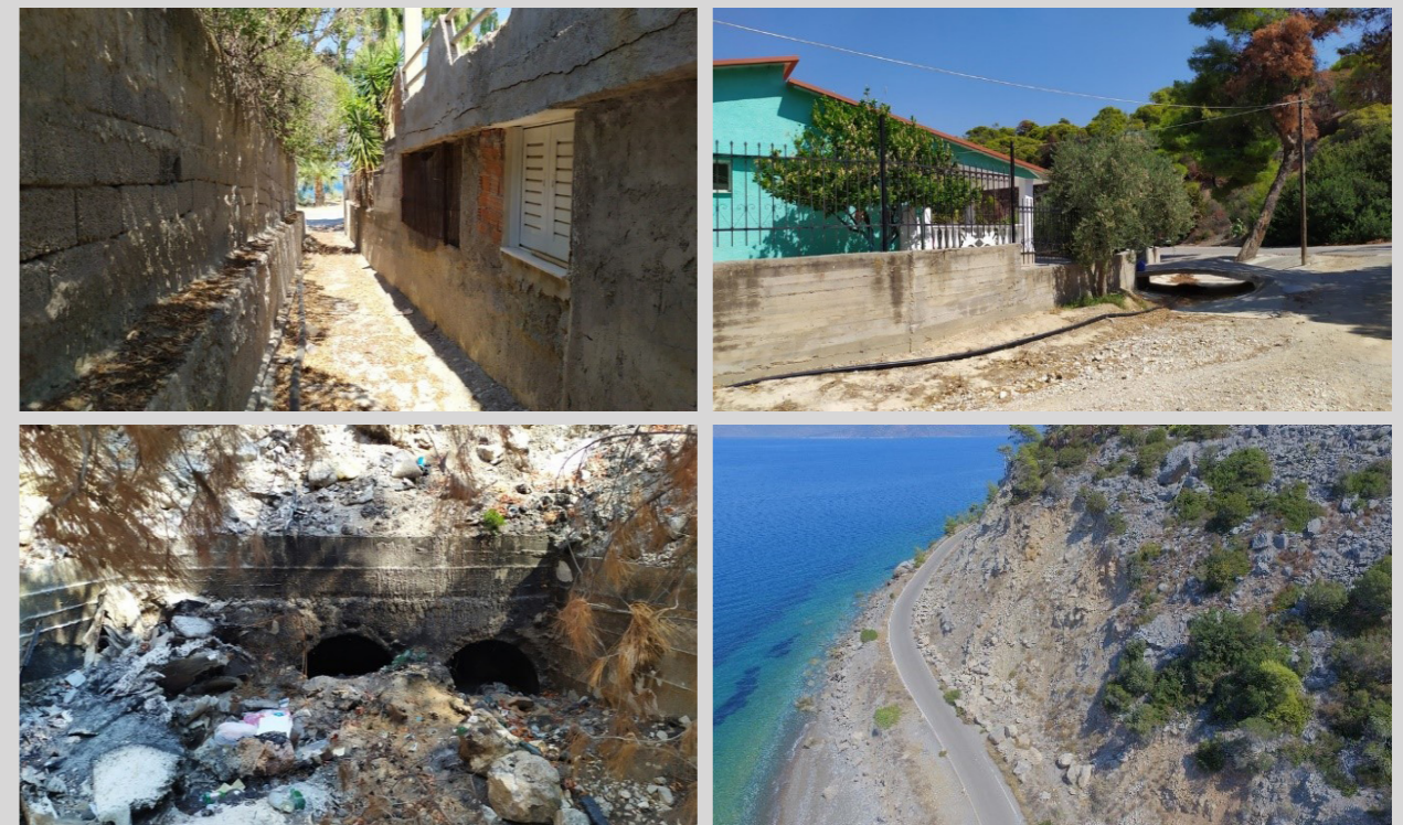
Εικόνες 11-14: Ενδεικτικές φωτογραφίες κρίσιμων σημείων που εντοπίστηκαν για πλημμύρα και κατολίσθηση.
